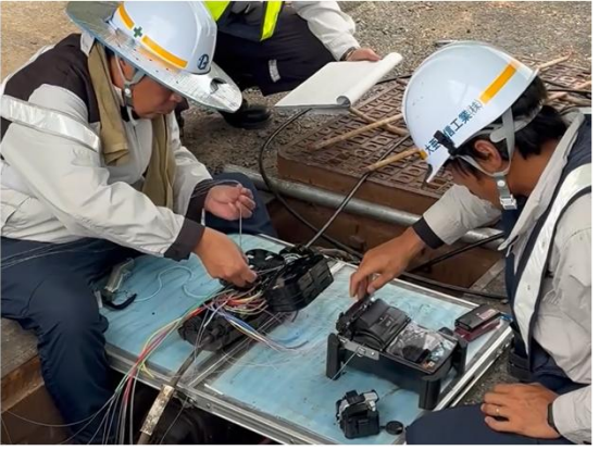
通信ケーブル接続作業
