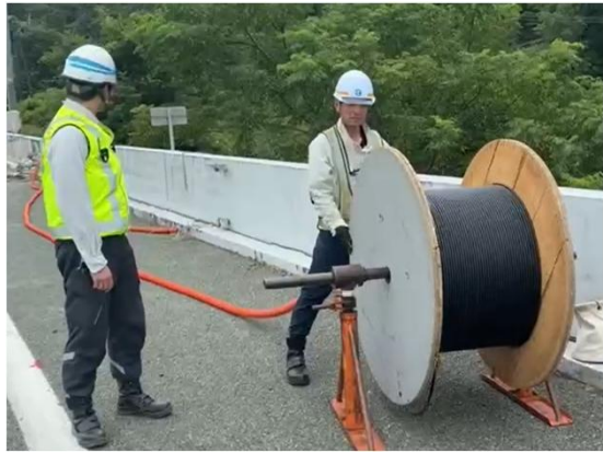
仮設ケーブル入線
