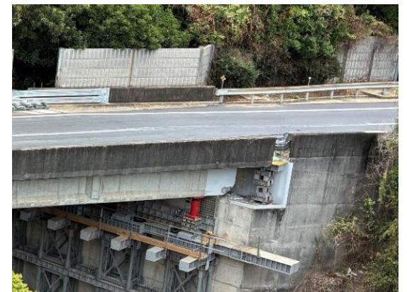
応急復旧(一般車両通行可能)
