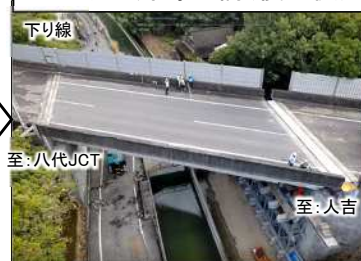
九州道 片野川橋(復旧後)
