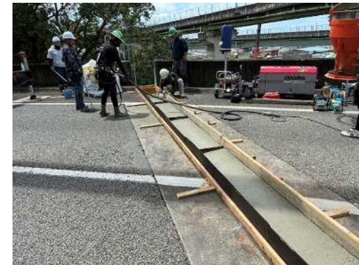
遊間部コンクリート打設
