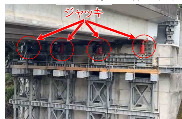
ジャッキアップ・鋼製支保工設置
