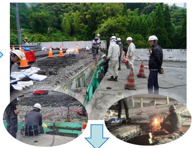
床版損傷部 応急復旧
