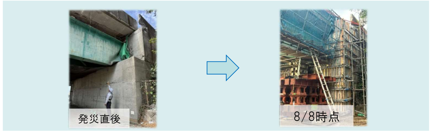
< 応急復旧状況 >
