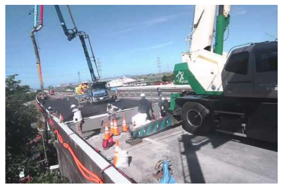
床版損傷部 応急復旧
