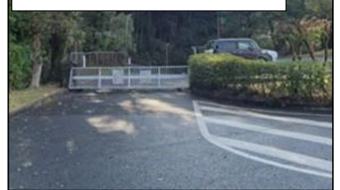
宮原 SA(下り線)緊急開口部
