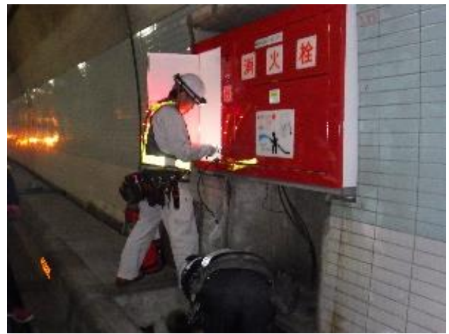
《トンネル設備点検》
