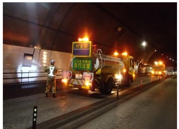
トンネル清掃
