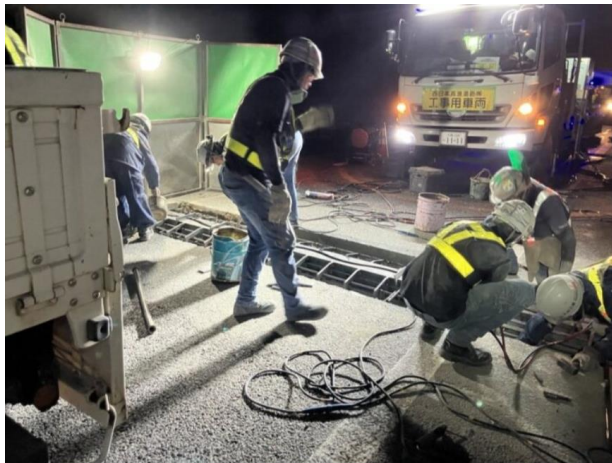
伸縮装置取替工事
