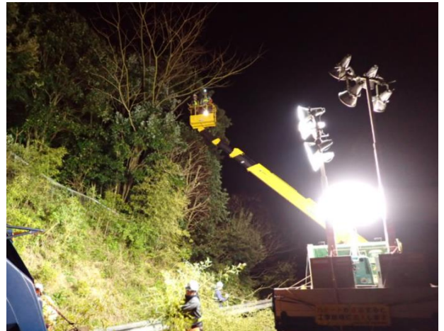
のり面伐採工事
