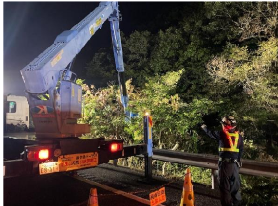
《支障木伐採作業状況》
