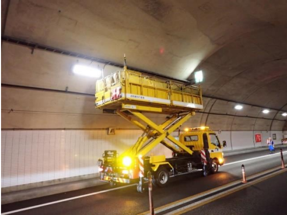
《トンネル内設備点検作業状況》
