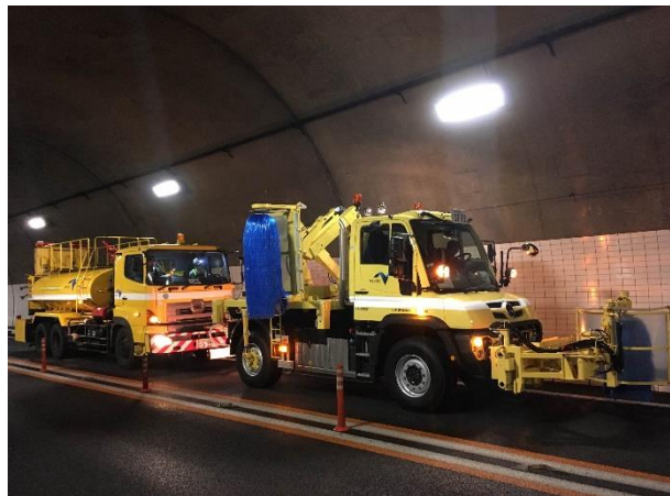
トンネル側壁清掃(イメージ)
