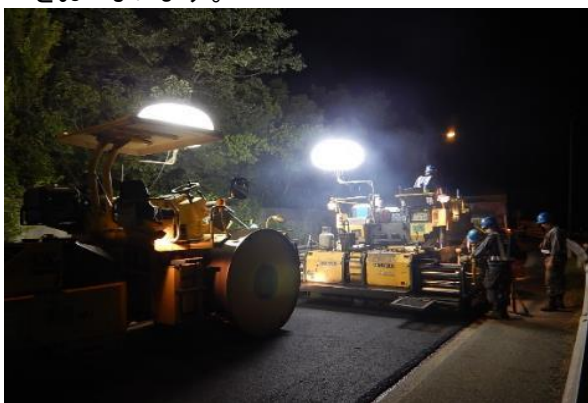
路面損傷箇所の補修(イメージ)
