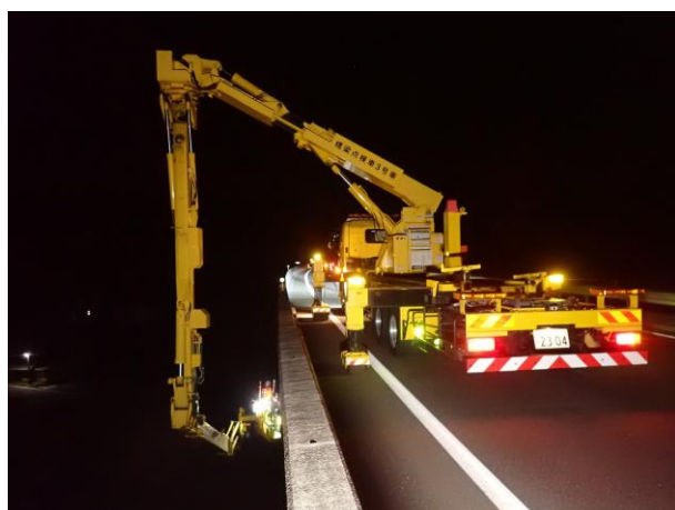
<構造物点検(橋梁)>
