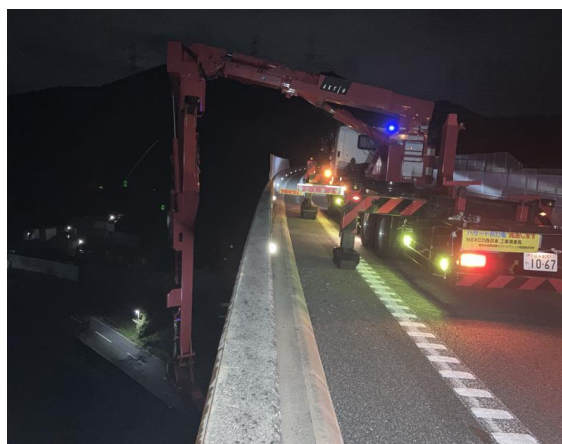
《橋梁点検状況》
