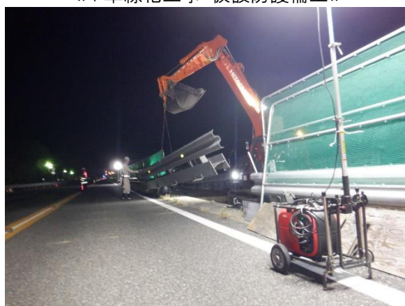
《4車線化工事:仮設防護柵工》
