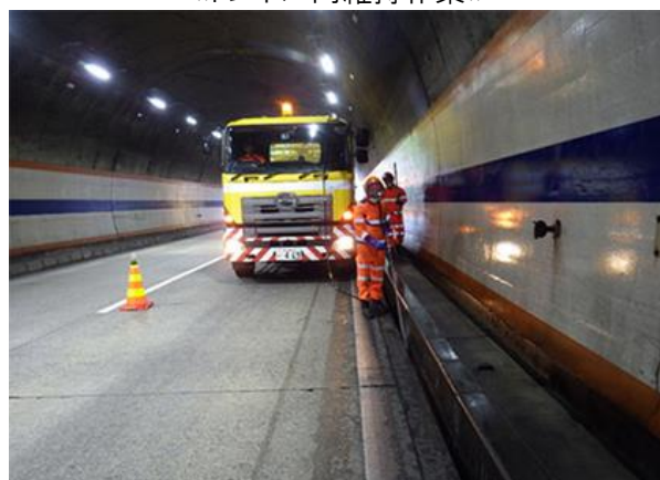
《4車線化工事:仮設防護柵工》
