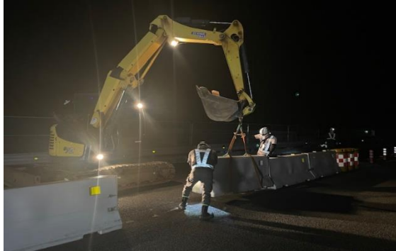
＜仮設防護柵設置工事＞
