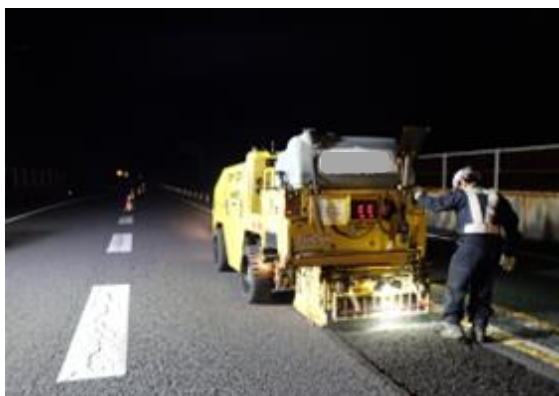
＜舗装補修工事＞
