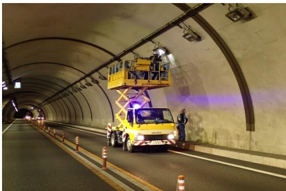
＜トンネル照明点検作業＞
