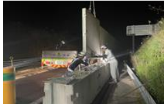
＜バリアウォール移設作業＞
