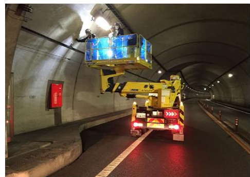
＜トンネル照明点検＞
