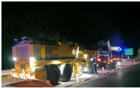
＜路面補修工事＞
