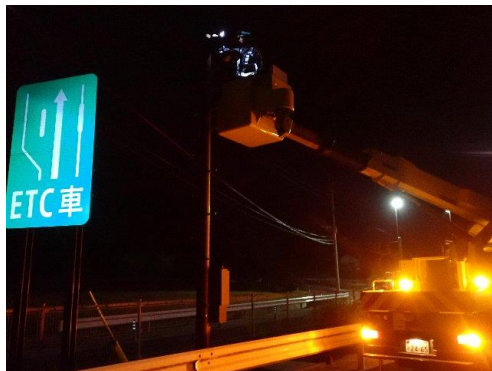
＜道路構造物点検＞
