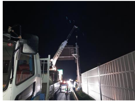
＜通信設備工事＞
