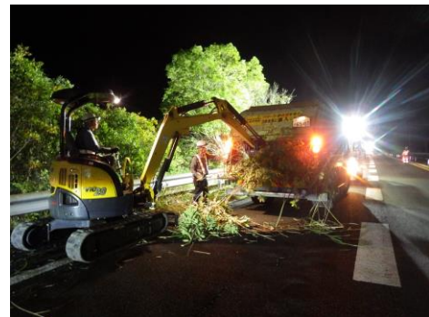
＜植栽伐採作業＞
