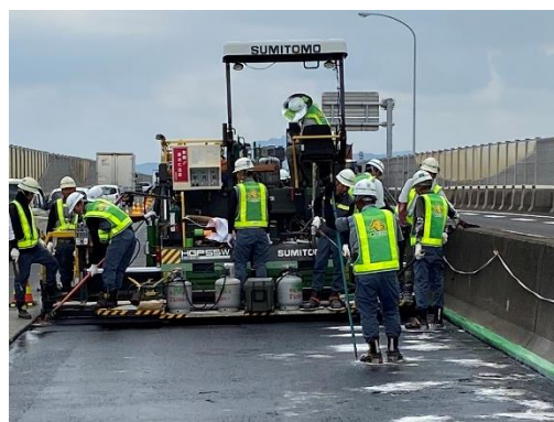
床版防水の施工
