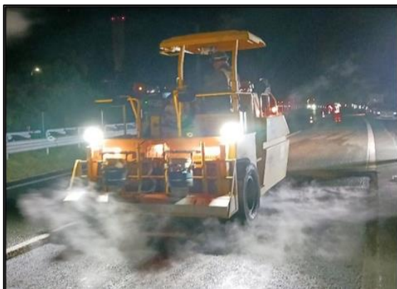
<舗装補修工>
