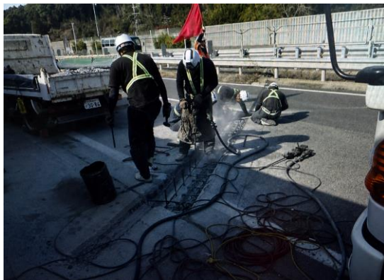
《 伸縮装置取替工事 》
