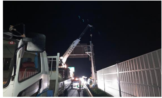
<通信設備工事>
