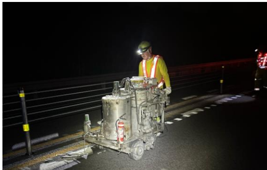
<事故復旧作業>
