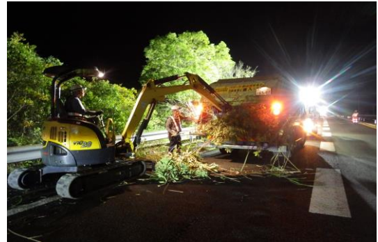
＜植栽伐採作業＞
