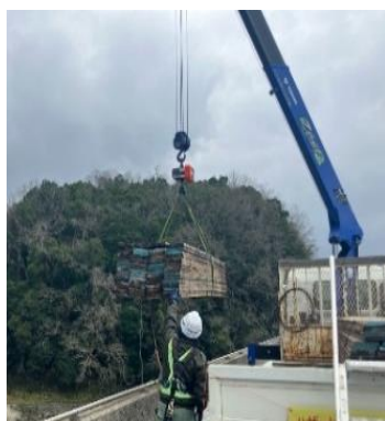
写真2：実重量管理(クレーンスケールによる計量)
