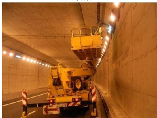
《トンネル内照明設備清掃(作業イメージ)》
