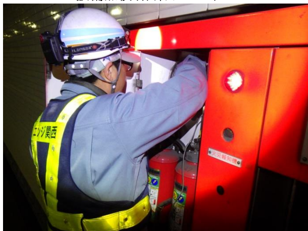
《設備点検(作業イメージ)》
