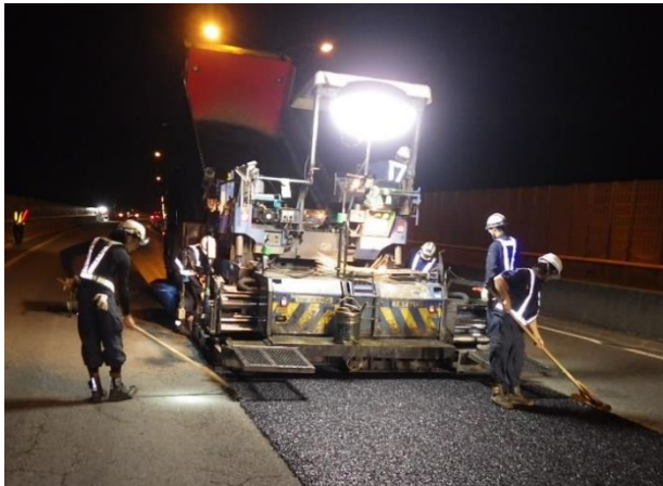
《舗装補修工事(作業イメージ)》
