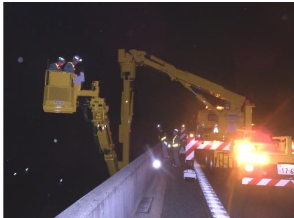
《橋梁点検・補修作業(作業イメージ)》
