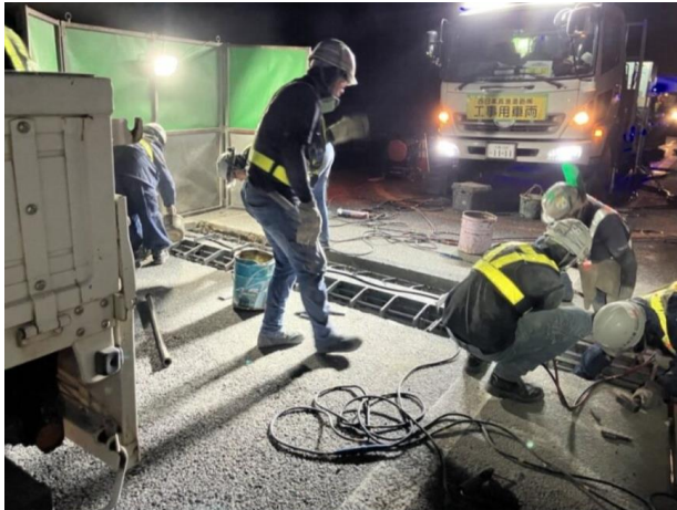
伸縮装置取替工事
