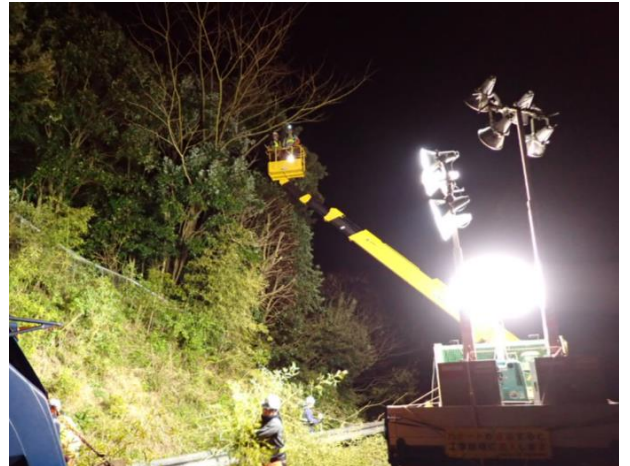
のり面伐採工事
