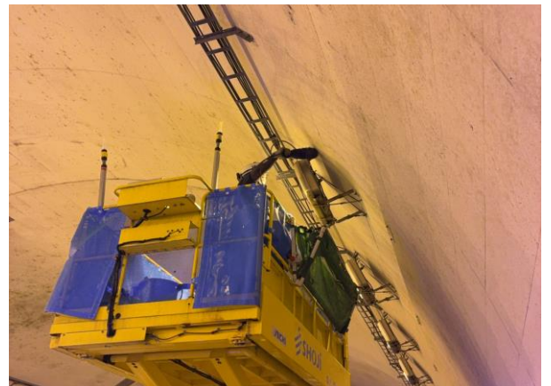
照明取替工事
