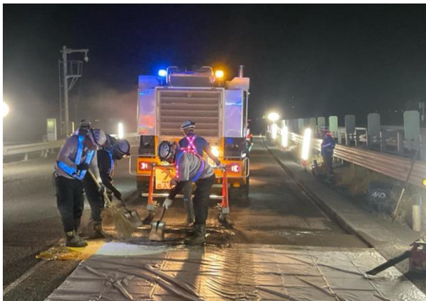
舗装補修工事
