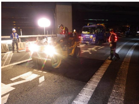
《舗装補修工事(施工イメージ)》
