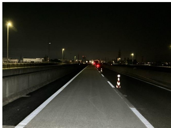
《路面標示工事(施工後イメージ)》
