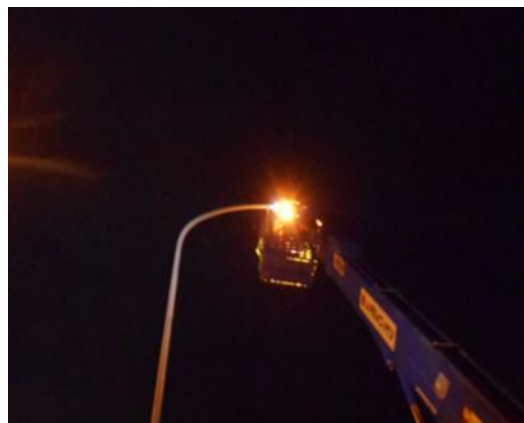
《道路照明点検(作業イメージ)》
