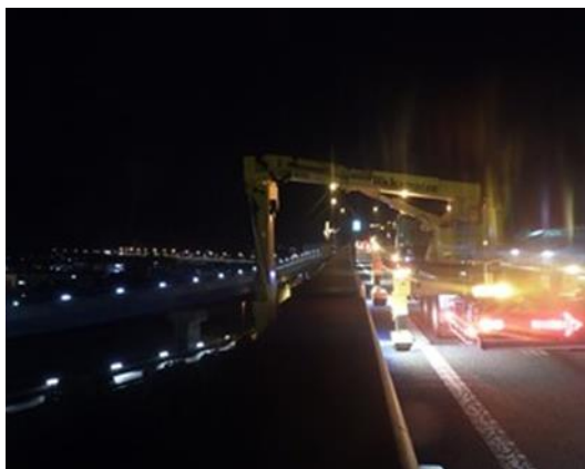
《橋梁点検(作業イメージ)》
