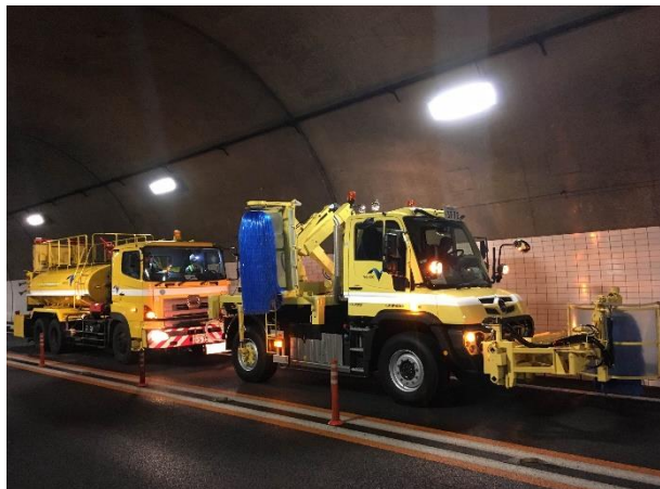
トンネル側壁清掃(イメージ)
