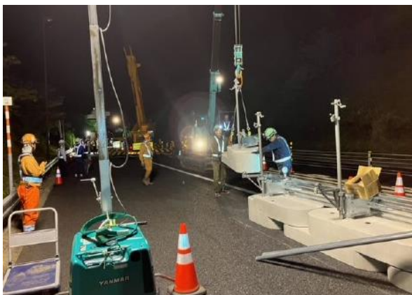
仮設防護柵設置(イメージ)
