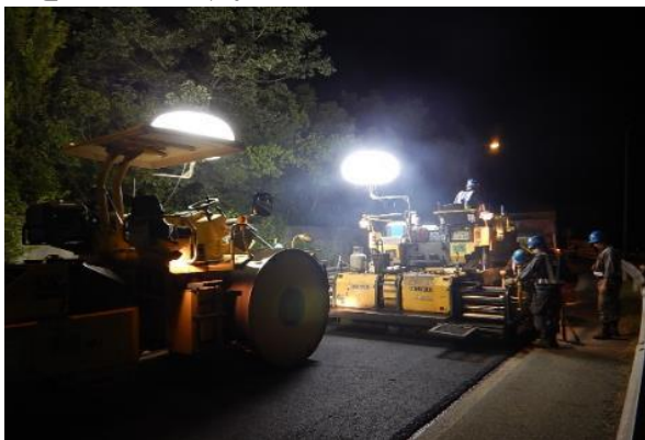
路面損傷箇所の補修(イメージ)
