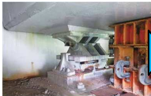
① 支承取替
