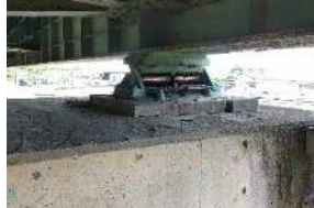
P2: すべり支承状況
