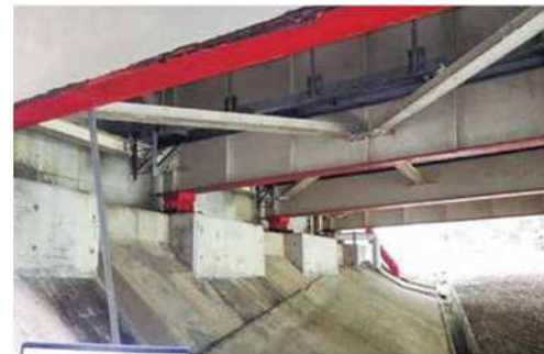
② 落橋防止構造
