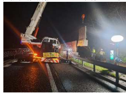
《仮設防護柵撤去工(4 車線化工事)》
