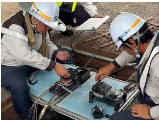
通信ケーブル接続作業
