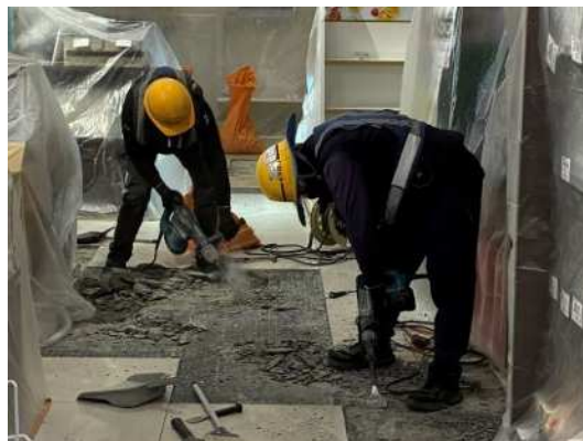
応急復旧作業
