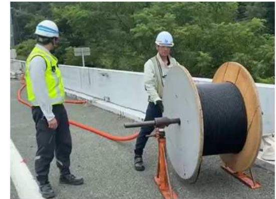
仮設ケーブル入線
