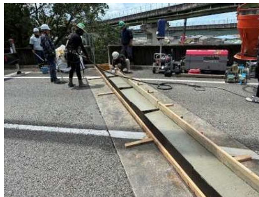
遊間部コンクリート打設
