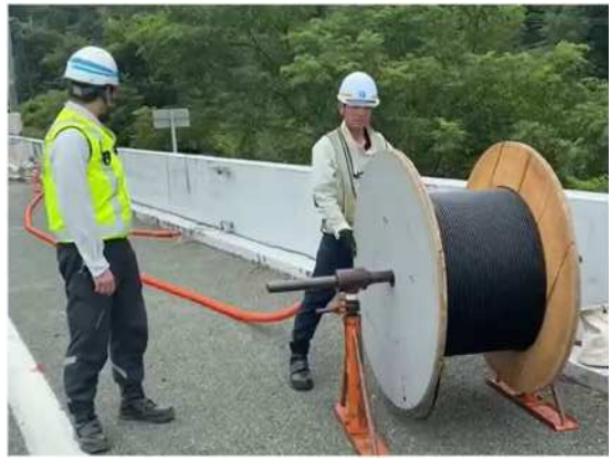
仮設ケーブル入線
