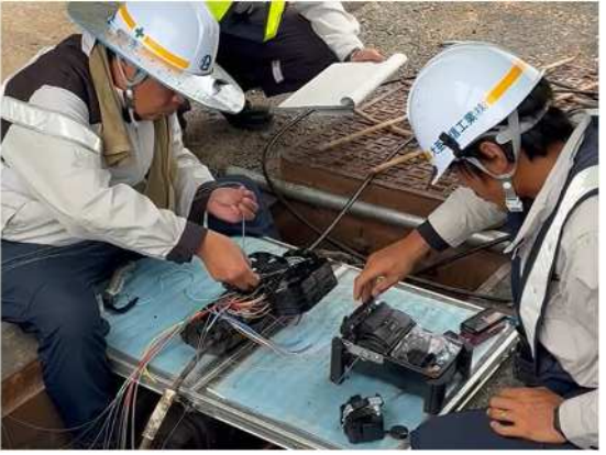
通信ケーブル接続作業
