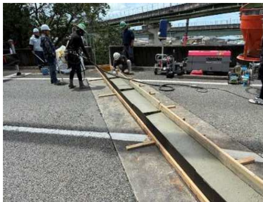
遊間部コンクリート打設
