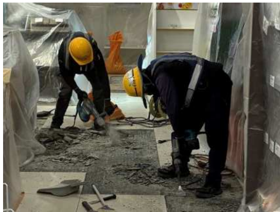
応急復旧作業
