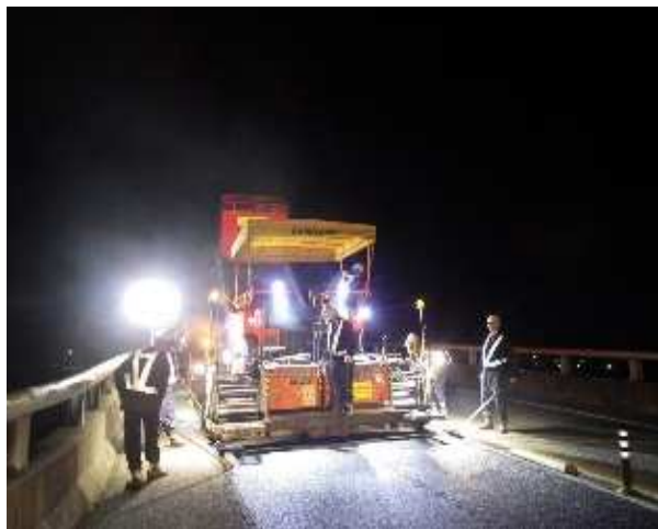
《舗装補修工事》
