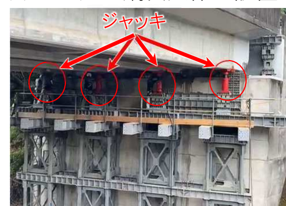
ジャッキアップ・鋼製支保工設置
