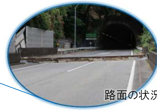
橋桁のずれ、 ジョイント損傷
