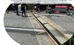
遊間部コンクリート打設
