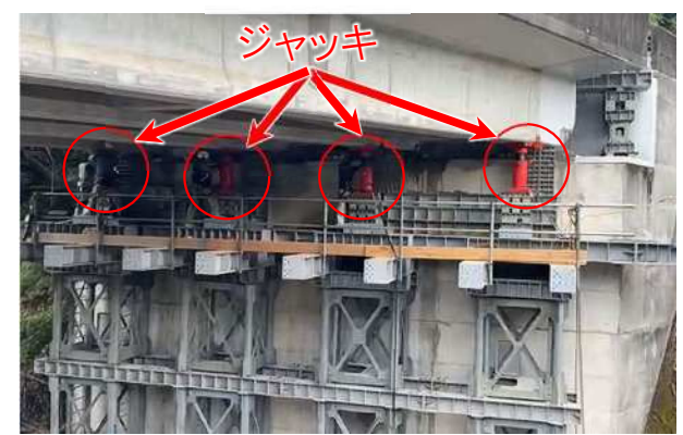
ジャッキアップ・鋼製支保工設置
