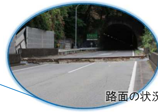
橋桁のずれ、 ジョイント損傷
