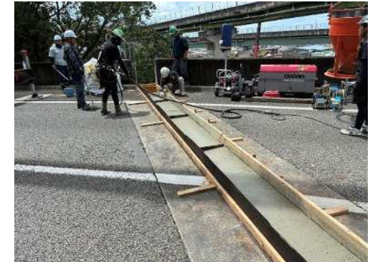
遊間部コンクリート打設
