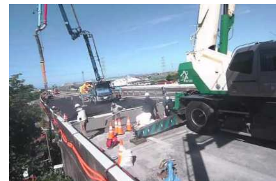
床版損傷部 応急復旧
