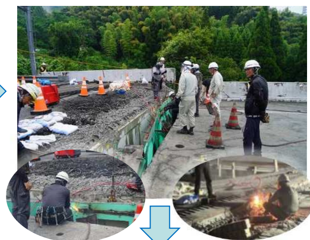
床版損傷部 応急復旧
