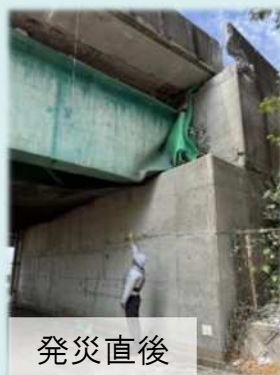
< 応急復旧状況 >
