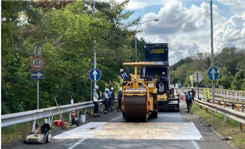
《舗装補修工事》
