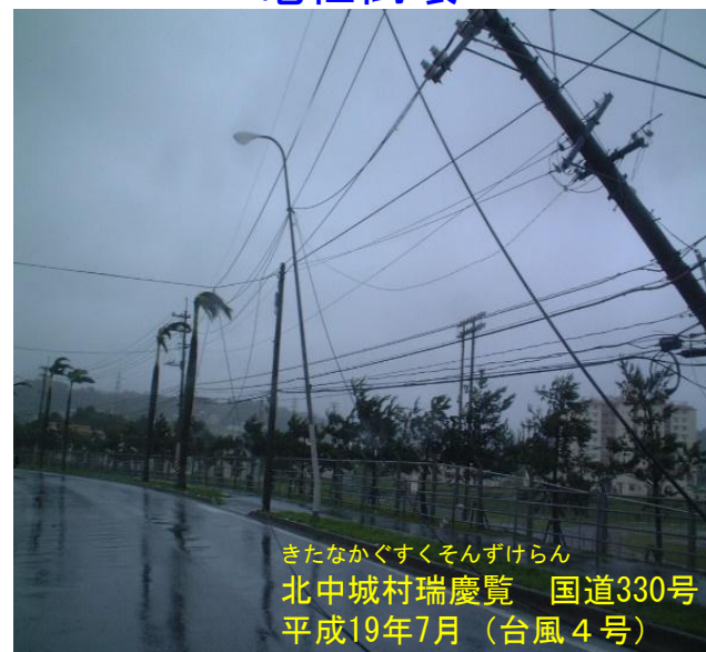
電柱倒壊
