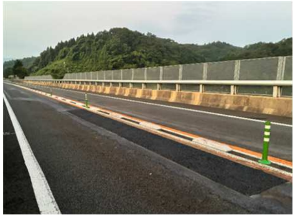
《補修箇所① 施工後》
