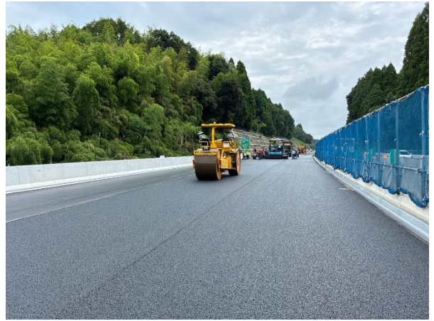
舗装工事の作業状況
