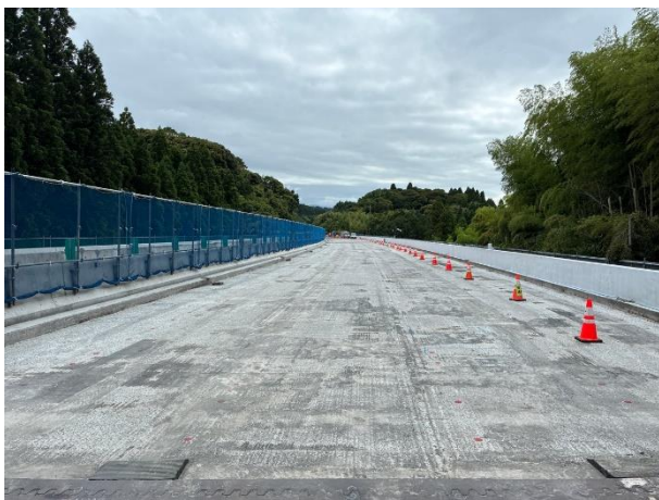
床版取替 施工前
