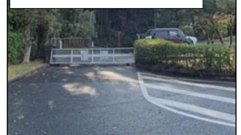
宮原 SA(下り線)緊急開口部
