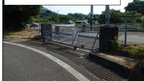
宮原 SA(上り線)緊急開口部
