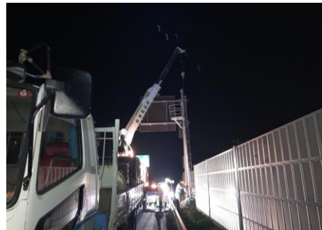
〈通信設備工事〉
