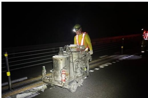
〈路面標示作業〉
