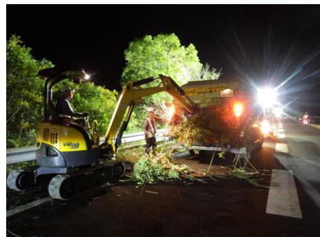
〈植栽伐採作業〉
