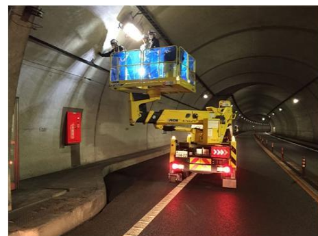
〈トンネル照明点検〉
