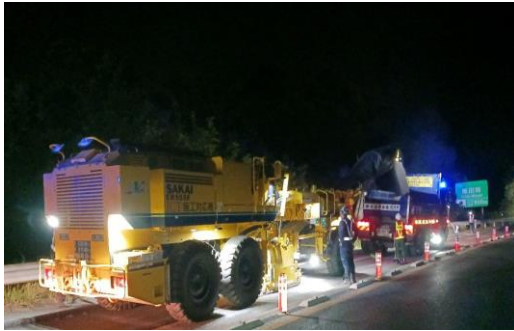
〈舗装(路面)補修工事〉
