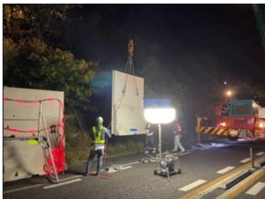
【四車線化工事】〈仮設防護柵設置〉
