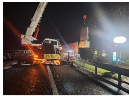
《仮設防護柵撤去工(4 車線化工事)》
