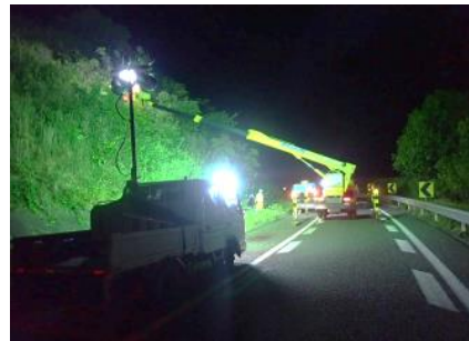
《仮設防護柵撤去工(4 車線化工事)》
