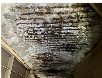
(有野川橋床版下面)
