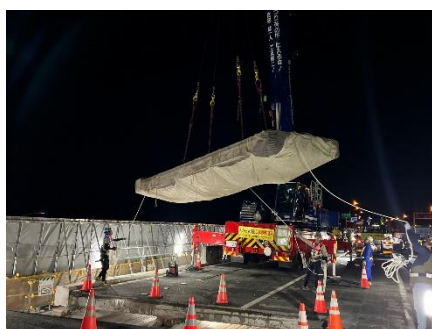
(既設床版撤去)
