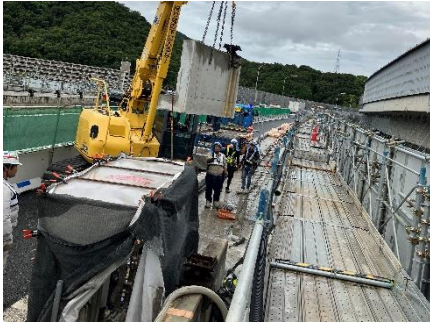
(既設壁高欄撤去)
