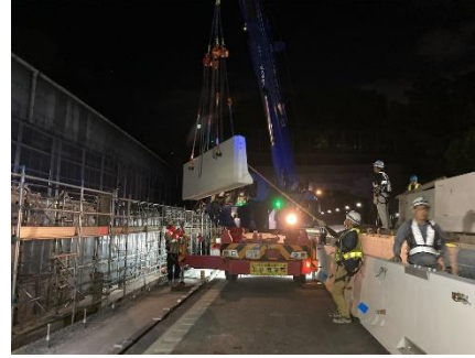
(新設壁高欄架設)
