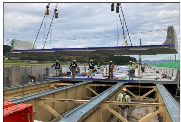
(新しいコンクリート床版の設置状況)
