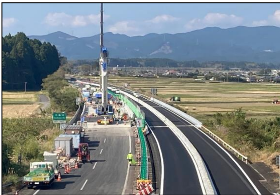
(対面通行規制の状況)
