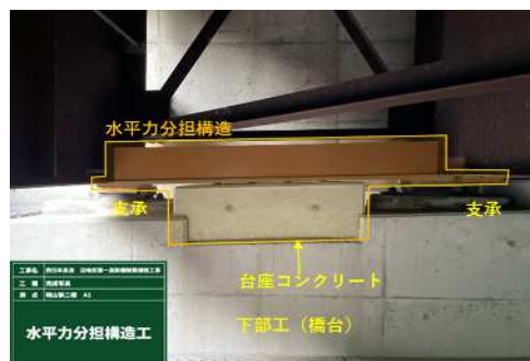
水平力分担構造(施工後)
