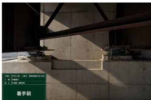
水平力分担構造(施工前)
