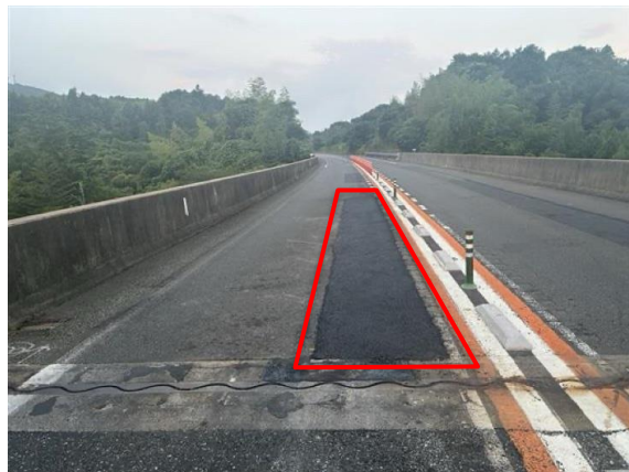
《補修箇所① 施工後》
