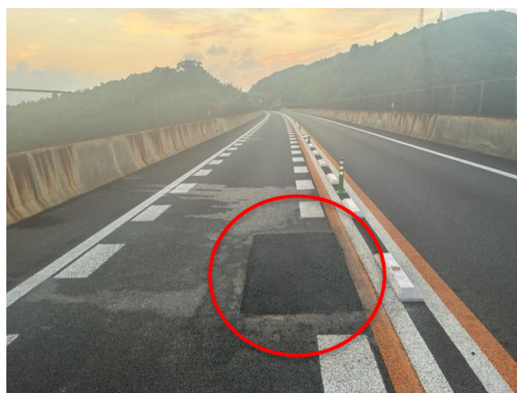
《補修箇所② 施工後》
