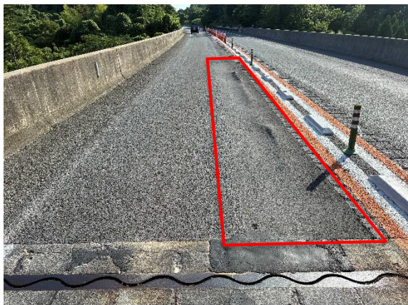
《補修箇所① 施工前》
