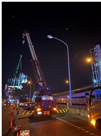
《FF アンテナ撤去 作業中》
