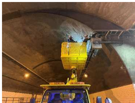
トンネル内設備点検
