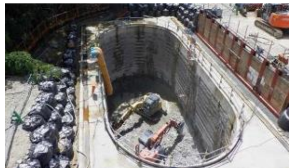
大口径深礎の施工
