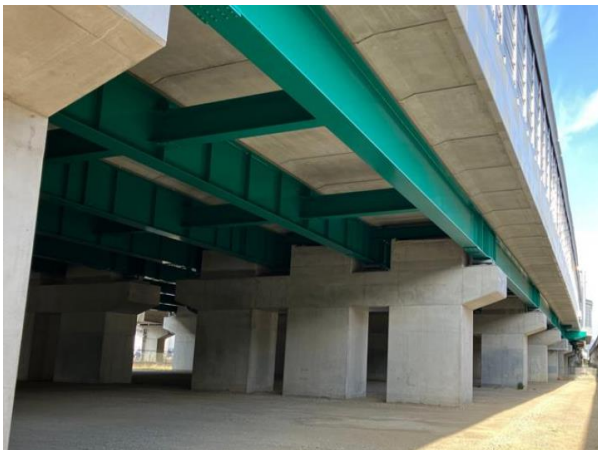
橋梁更新後の写真（鋼桁橋）
