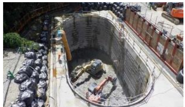
大口径深礎の施工
