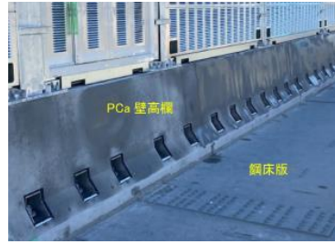
鋼床版での PCa 壁高欄の適用
