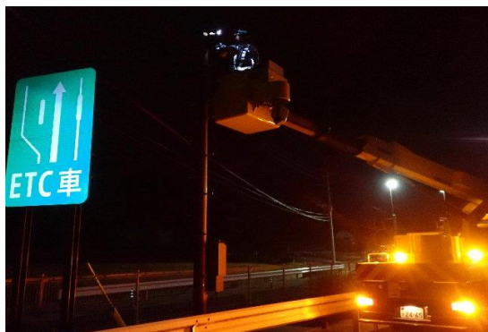
<道路構造物点検>
