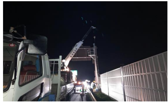
<通信設備工事>
