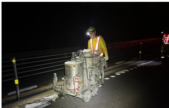
<事故復旧作業>
