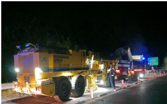
<路面補修工事>
