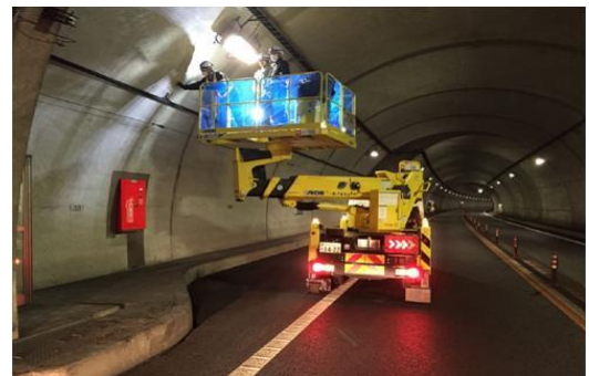
<トンネル照明点検>
