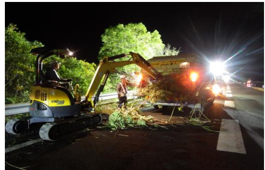
<植栽伐採作業>
