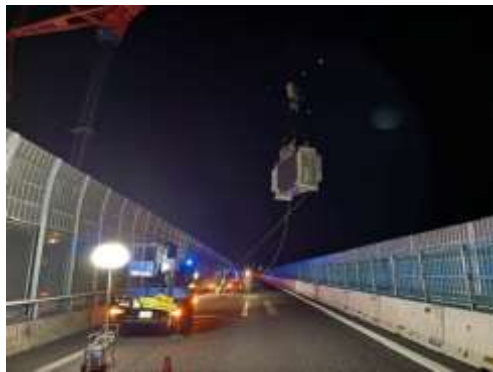
橋梁の桁架設
