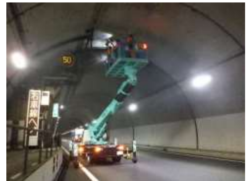
トンネルの点検
