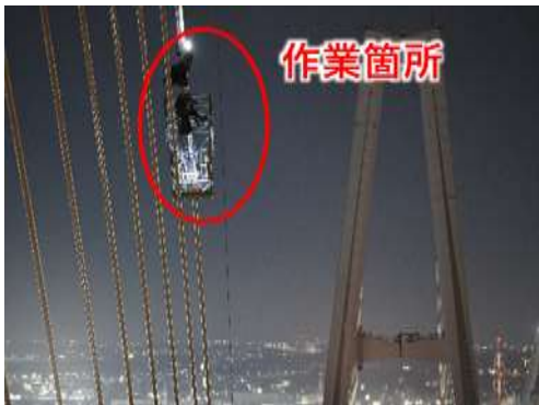
ロープ高所作業の状況(遠景)
