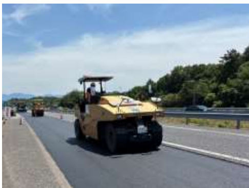
新しい舗装の舗設
