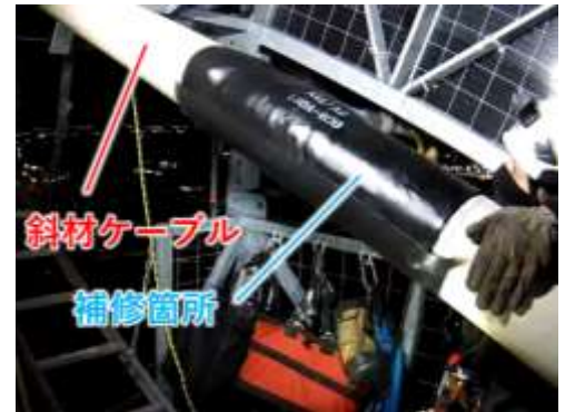
ロープ高所作業の状況(近景)
