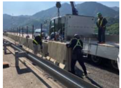
車線を拡幅するために必要となる 仮設防護柵の設置
