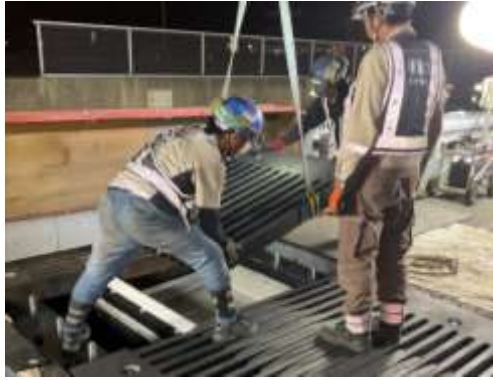
新しい伸縮装置部材の設置
