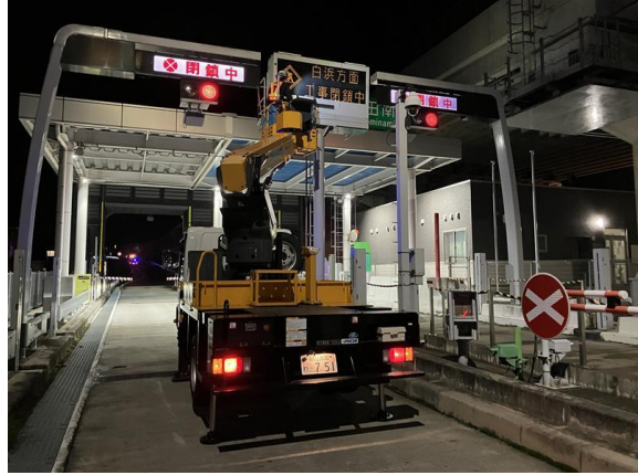
《情報板点検状況》
