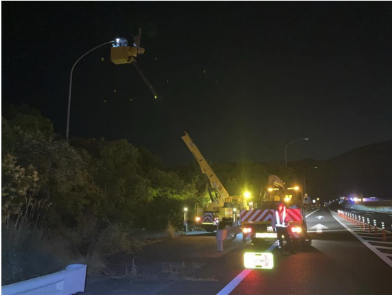
《照明点検状況》
